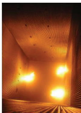
Рис. 30. Демонстрационный вид сверху топки СРК
